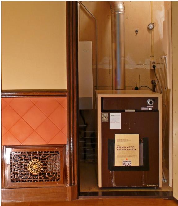
Vervanging van de links afgebeelde VR-ketel uit 1988 met aparte geiser voor warm tapwater door een condenserende HR-combiketel leverde een besparing op het gasgebruik op van ruim 40%. Voor dit monumentale woonhuis van ca. 600 m 3 inhoud betekende dit dat de investering binnen 3 jaar was terugverdiend!. © ejn
