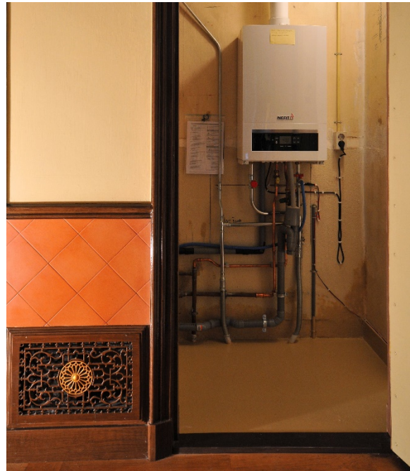
Vervanging van de links afgebeelde VR-ketel uit 1988 met aparte geiser voor warm tapwater door een condenserende HR-combiketel leverde een besparing op het gasgebruik op van ruim 40%. Voor dit monumentale woonhuis van ca. 600 m 3 inhoud betekende dit dat de investering binnen 3 jaar was terugverdiend!. © ejn
